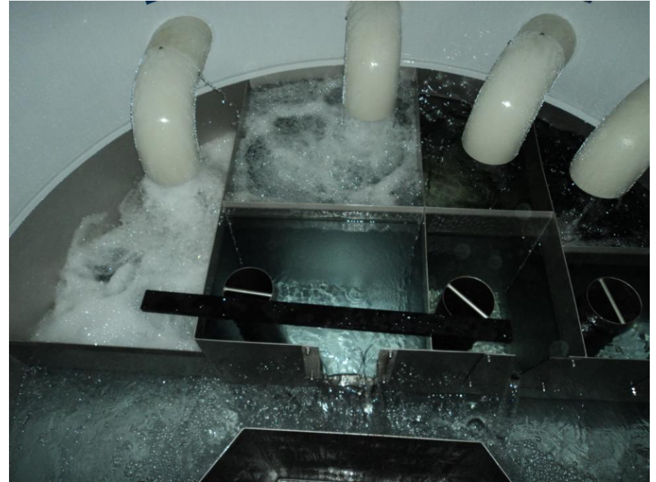
Nuova vasca di captazione per quattro sorgenti a Not/Fop, Roticcio, 2011
